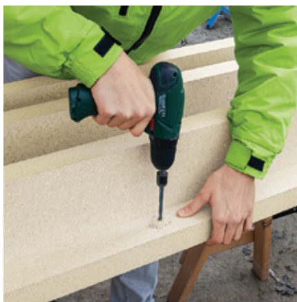
Obr. 2: Predvrtanie otvorov pre poistné skrutky
