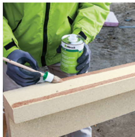
Obr. 3: Príprava lepených plôch podkladným náterom illbruck AT140
