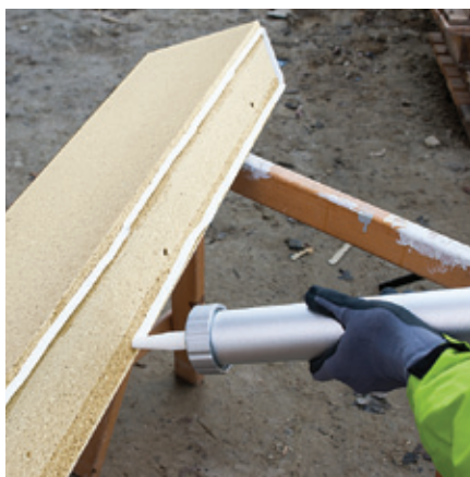
Obr. 5: Aplikácia lepidla SP340 na rám v dvoch húsenkách
