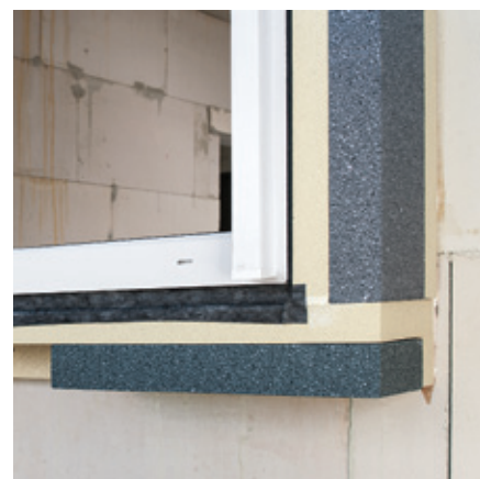
Obr.9: Aplikácia membrány ME503 TwinAktiv VZ proti tlakovej vode a izolačných klinov PR012
